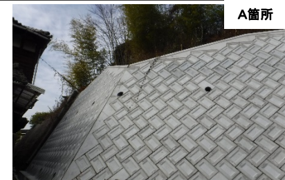
工事完了（令和3年1月29日）
