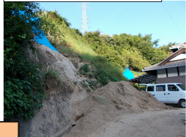
斜面崩壊・被災状況（H30年7月）
