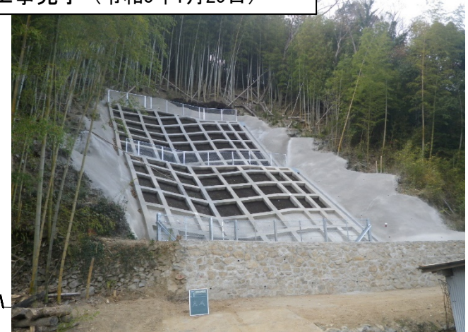
工事完了（令和3年1月25日）
