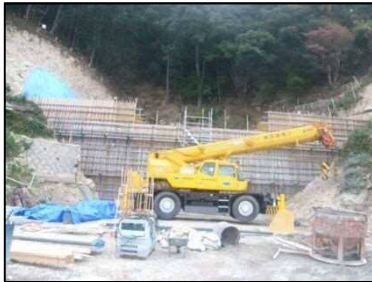
県砂防事業 バイシ川隣 (江田島市江田島町)
