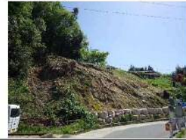
斜面崩壊・被災状況（H30年7月）
