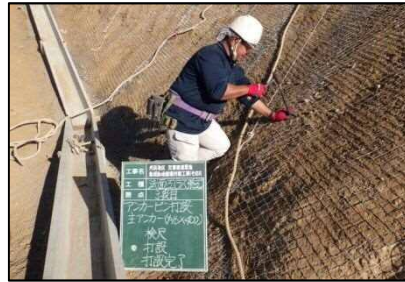
県急傾斜事業 刈浜地区 (呉市蒲刈町)
