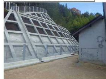
工事完了（令和2年12月3日）
