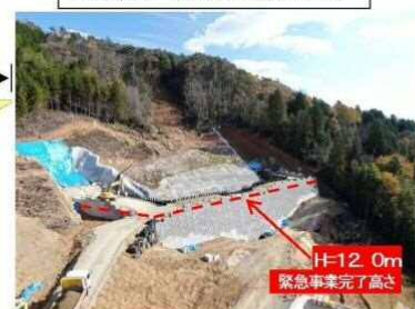
工事完了（令和2年12月11日）
