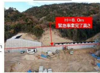
工事完了（令和2年12月1日）
