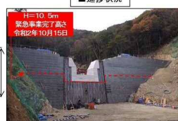
工事完了（令和2年12月15日）
