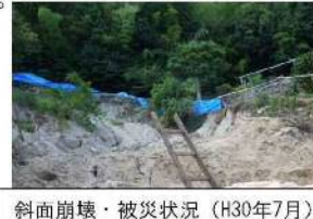
斜面崩壊・被災状況（H30年7月）
