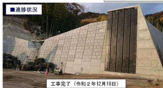
工事完了（令和2年12月18日）
