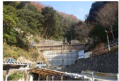
県治山事業 別両路地区 (府中市荒谷町)
