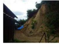
斜面崩壊・被災状況（平成30年8月）
