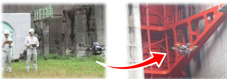
ドローンを活用した施設点検
