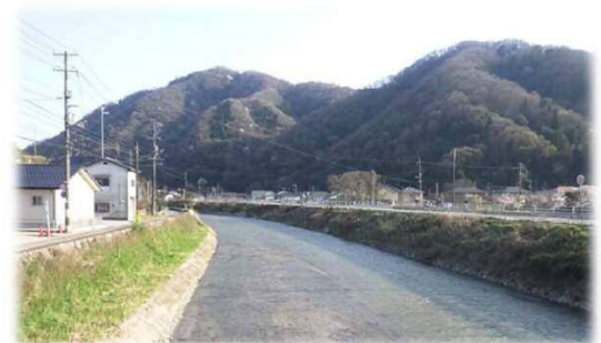
河川堆積土等の除去
