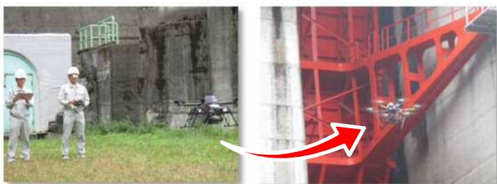
【ドローンを活用した施設点検】
