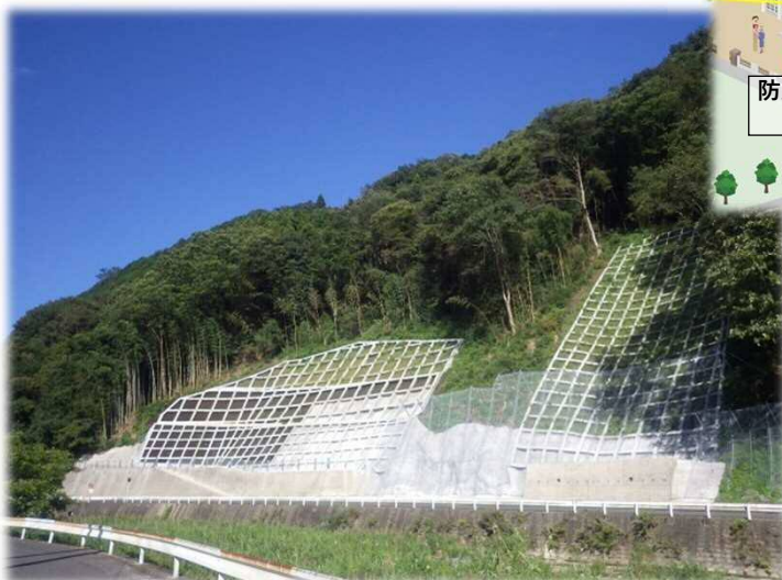
道路法面对策
