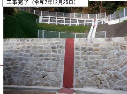
平成30年7月豪雨に伴い、安芸高田市向原町において発生した土砂災害（山腹崩壊）に対して、広島県が緊急的に実施している災害関連緊急治山事業山腹工事が、完成しました。（令和2年12月1日）
