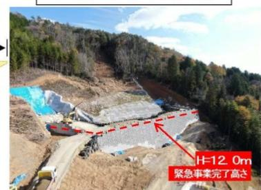
平成30年7月豪雨に伴い、尾道市吉和町において発生した土砂災害（土石流）に対して、広島県が緊急的に実施している災害関連緊急砂防事業について、堰堤工事（本堤部）の工事が完了しました。（令和2年12月11日）引き続き、地域の安全確保のため、堰堤下流部の工事を実施します。
