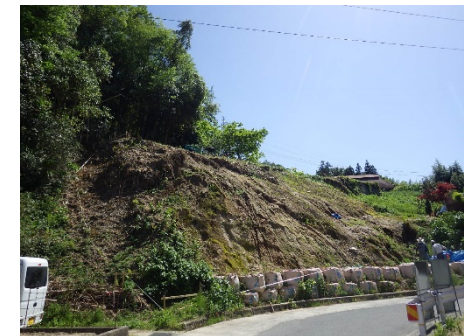
斜面崩壊・被災状況（H30年7月）
