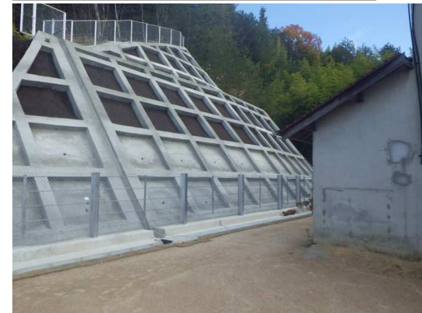
工事完了（令和2年12月3日）
