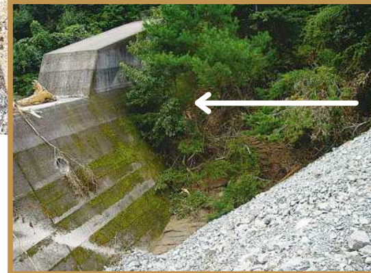
上原川(下流)砂防堰堤
