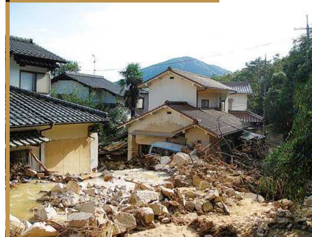
被災状況(安佐北区可部東6丁目)
