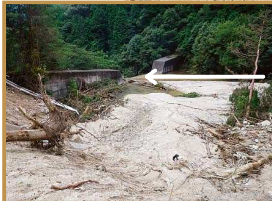
下の谷川砂防堰堤
