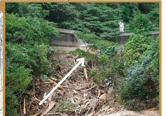
桧山川砂防堰堤
