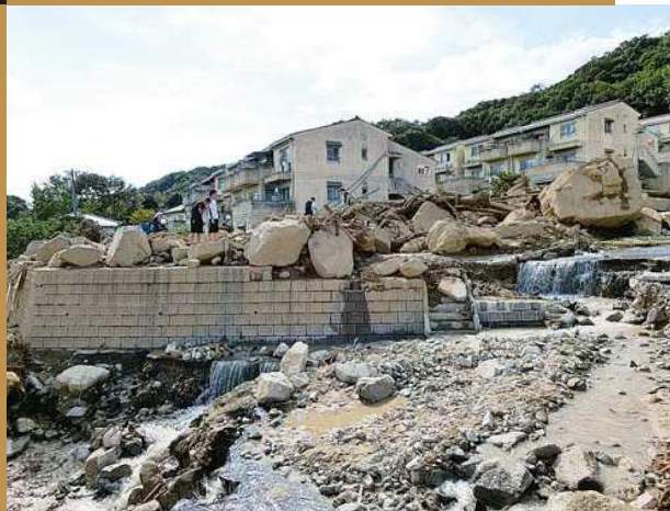
被災状況(安佐南区八木3丁目 県営緑丘住宅)
