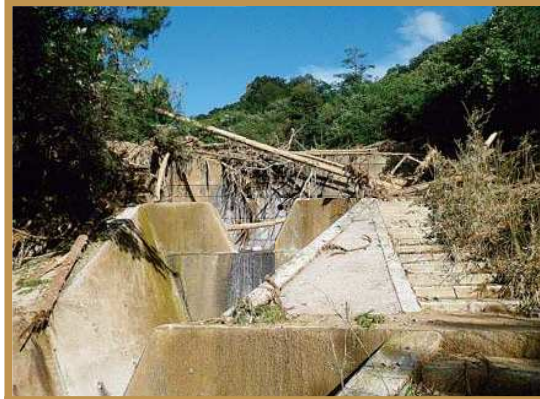
玖谷川砂防堰堤
