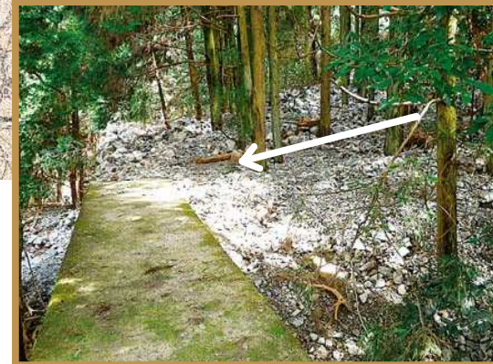
上原川(上流)砂防堰堤
