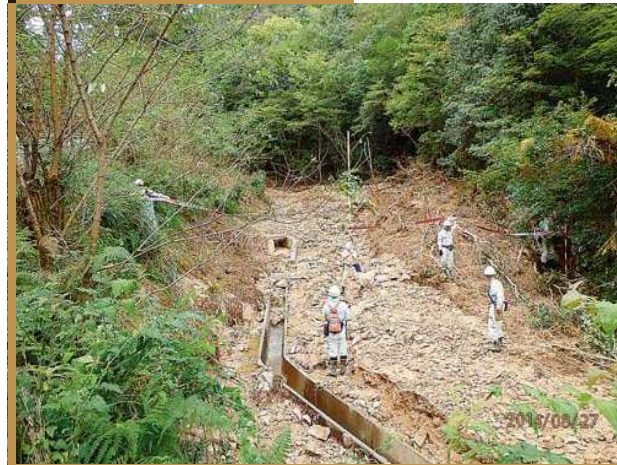
現地調査状況
