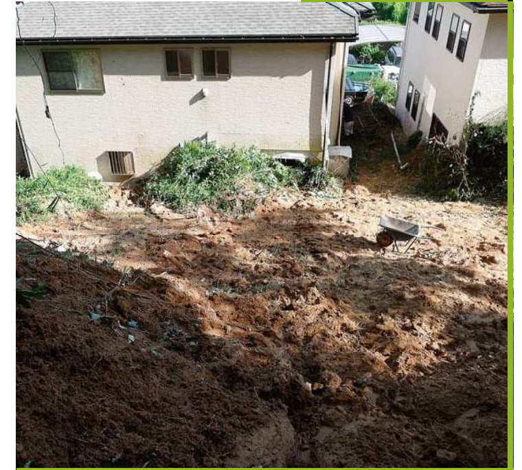
崩土の流出状況
