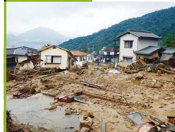
土砂の流出状況
