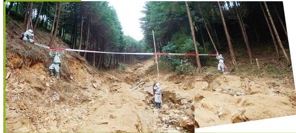
溪流の荒廃状況
