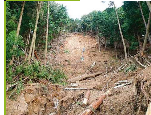
斜面崩壊状況
