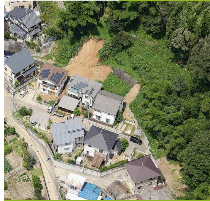
斜面崩壊状況
