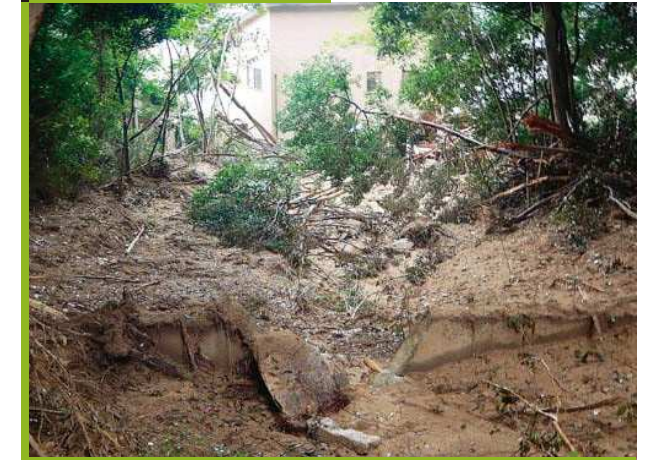
土砂の流出状況
