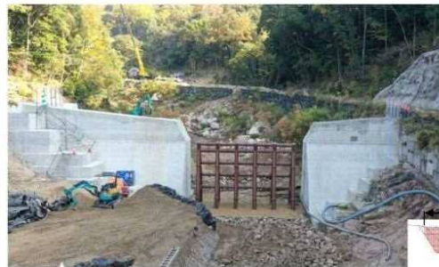
工事完了（令和2年11月20日）
