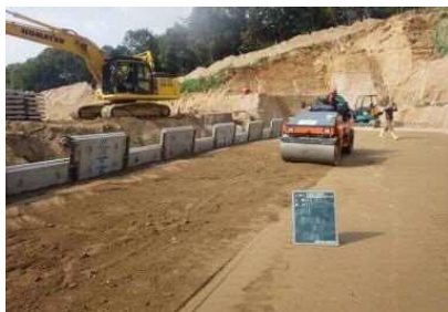
県砂防事業 東両谷川 (呉市広両谷)
