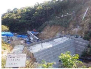
県砂防事業 南永谷川 (尾道市向島町)
