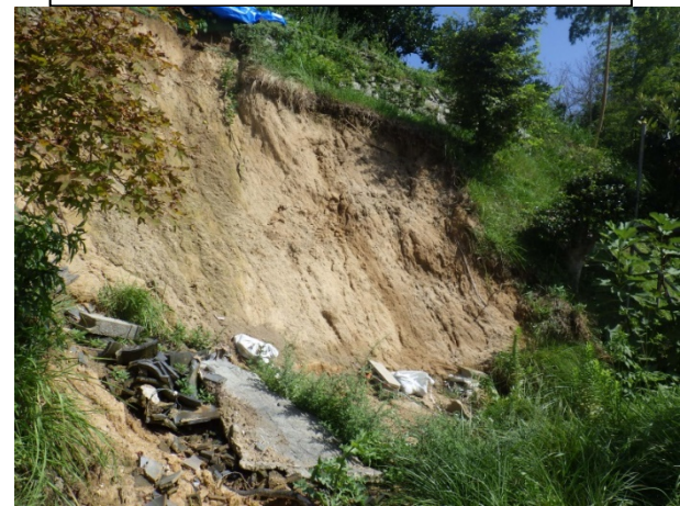
斜面崩壊・被災状況（H30年7月）
