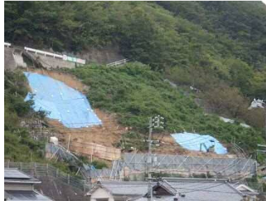
県急傾斜事業 刈浜地区 (呉市蒲刈町)
