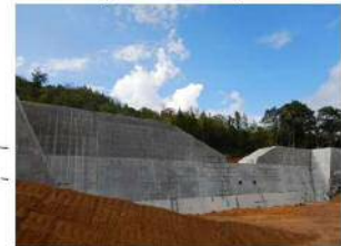
工事完了（令和2年9月30日）
