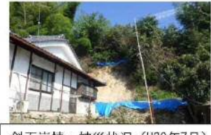
斜面崩壊・被災状況（H30年7月）
