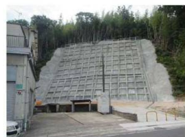
工事完了（令和2年9月30日）
