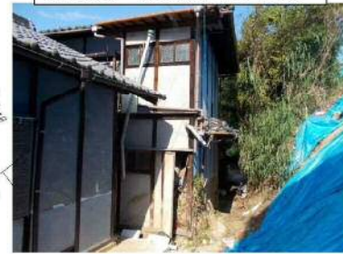
斜面崩壊・被災状況（H30年7月）
