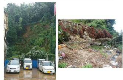
斜面崩壊・被災状況（平成30年7月）
