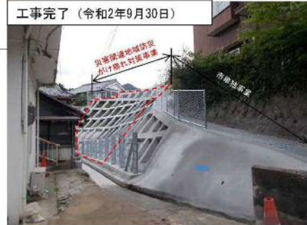
工事完了（令和2年9月30日）
