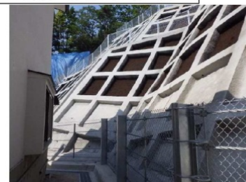
工事完了（令和2年9月11日）
