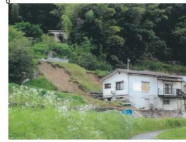
斜面崩壊・被災状況（平成30年8月）
