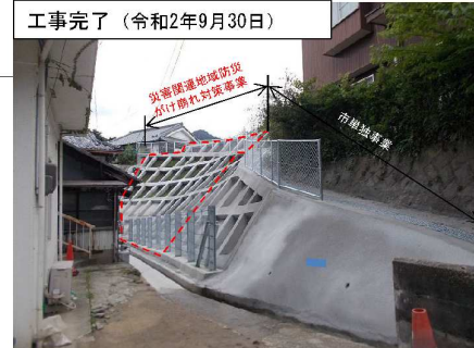
工事完了（令和2年9月30日）
