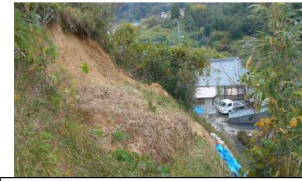
斜面崩壊・被災状況（H30年7月）
