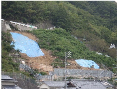
県急傾斜事業 刈浜地区 (呉市蒲刈町)
