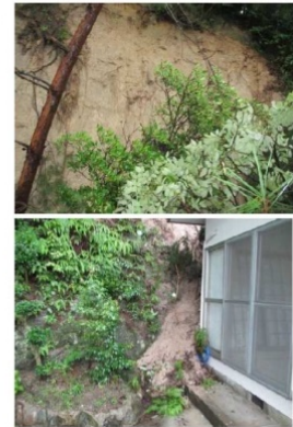
斜面崩壊・被災状況（H30年7月）
