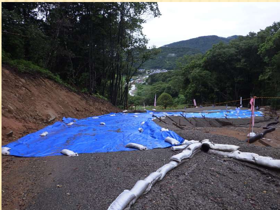
ブルーシート養生
