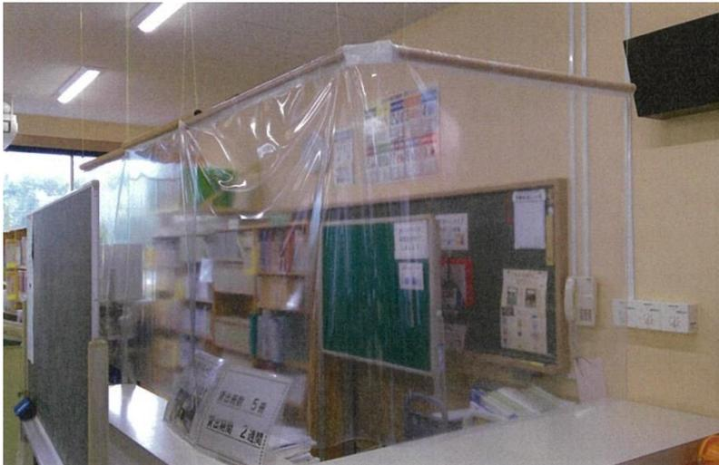
従来のカウンターにビニールカーテンを設置しました。釣り糸と模造紙の芯を利用し、天井から吊るしています。
