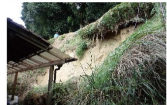
斜面崩壊・被災状況（H30年7月）
