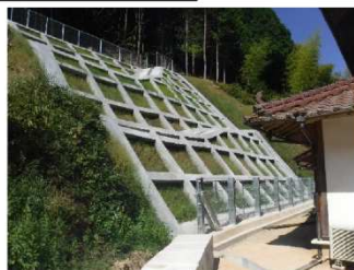
工事完了（令和2年8月31日）
