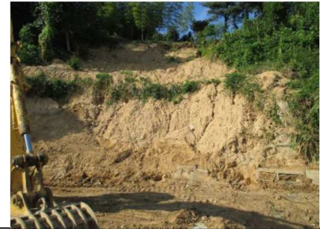
斜面崩壊・被災状況（H30年7月）
