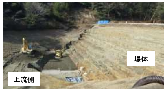
ため池の改修状況
