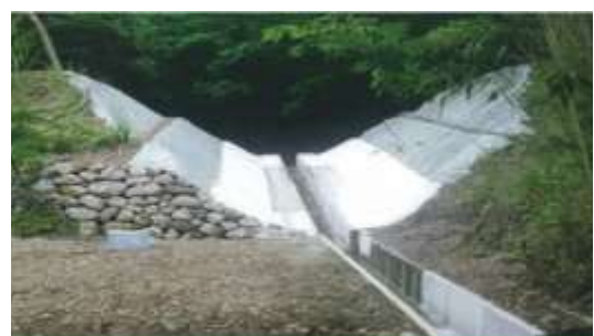
ため池の廃止工事
