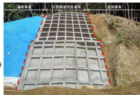
工事完了（令和2年6月30日）
