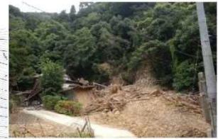
斜面崩壊・被災状況（H30年7月）
