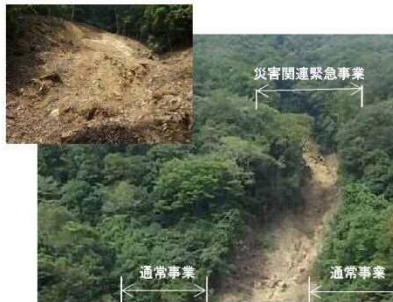
工事着手時（伐採後）
