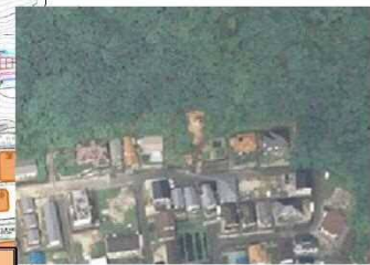
斜面崩壊・被災状況（H30年7月）
