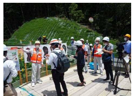
【7/2 天地川支川1 報道機関向け現場公開】
