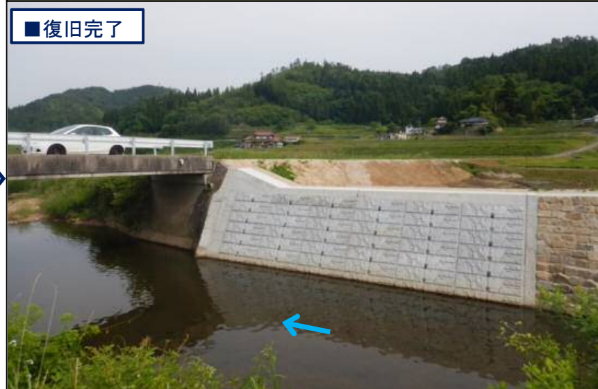
棕梨川(吉末橋上下)護岸完成【工事番号第3974号】
