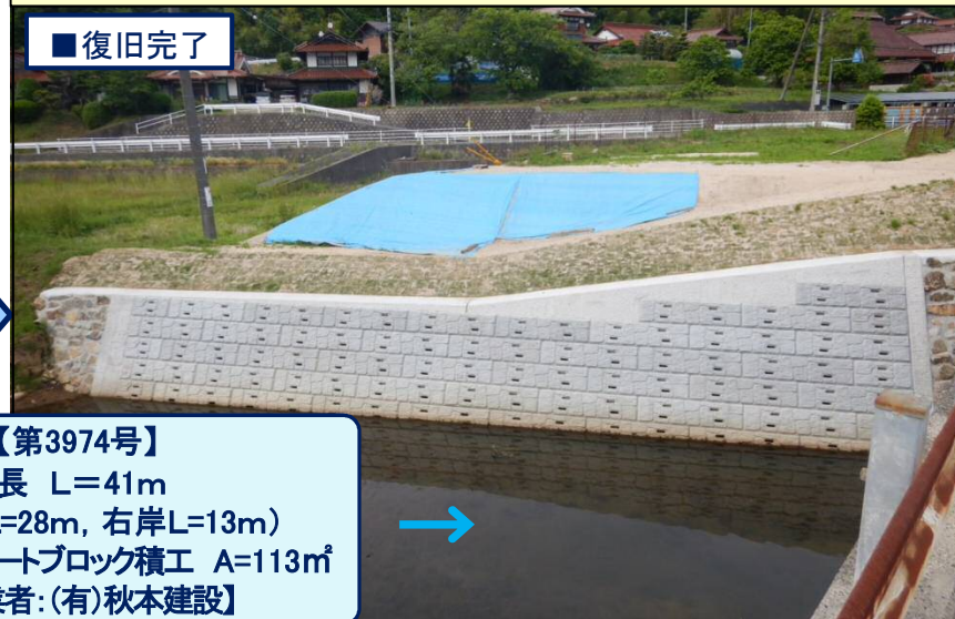
棕梨川(吉末橋上下)護岸完成【工事番号第3974号】
