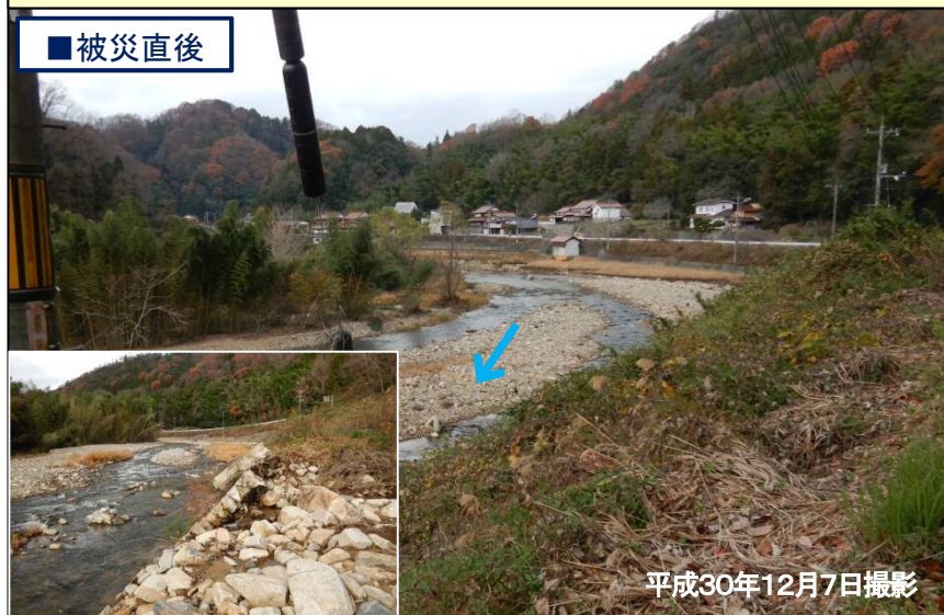
豪雨により沼田川が氾濫 護岸が流失
