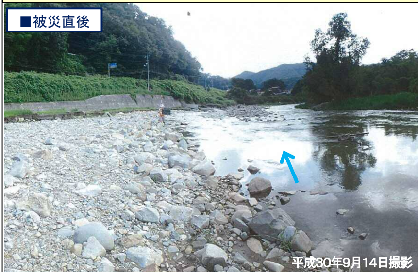
豪雨により沼田川が氾濫 護岸が流失
