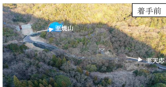
《主要地方道 呉環状線【災害関連事業】の進捗状況》
