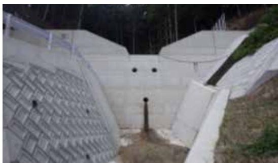
砂防堰堤(土石流対策)
