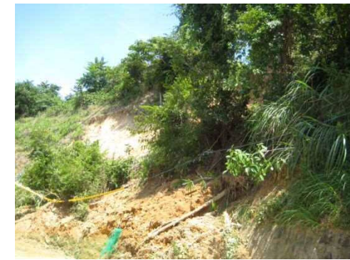
斜面崩壊・被災状況（H30年7月）
