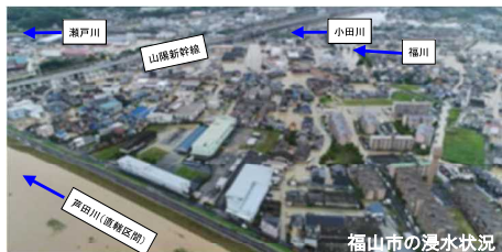
福山市の浸水状況
