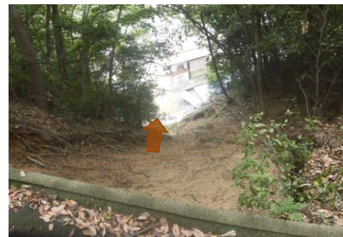
斜面崩壊・被災状況（H30年7月）
