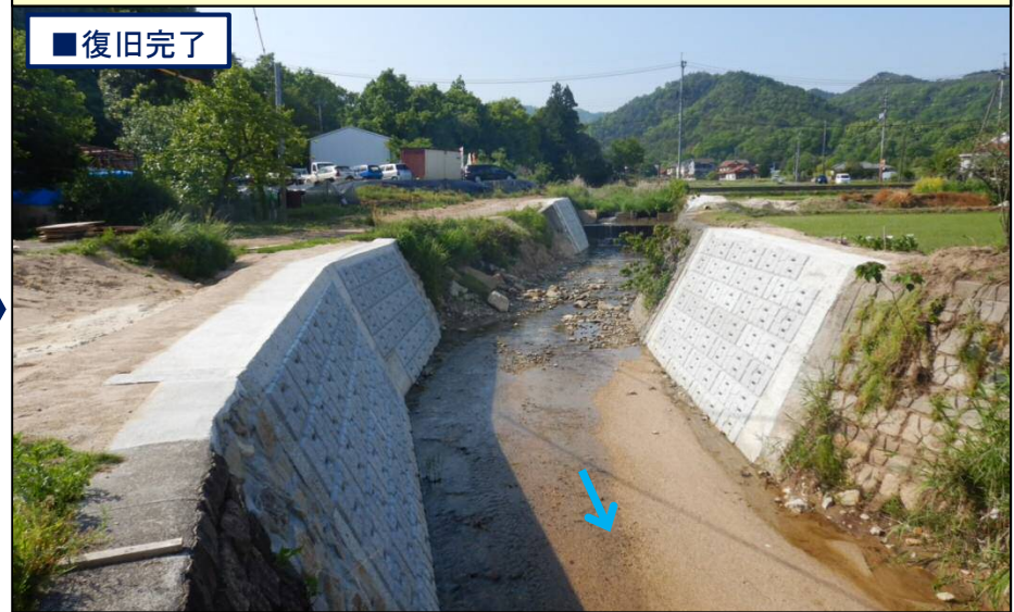
河川護岸の災害復旧工事が完成(令和2年5月)
