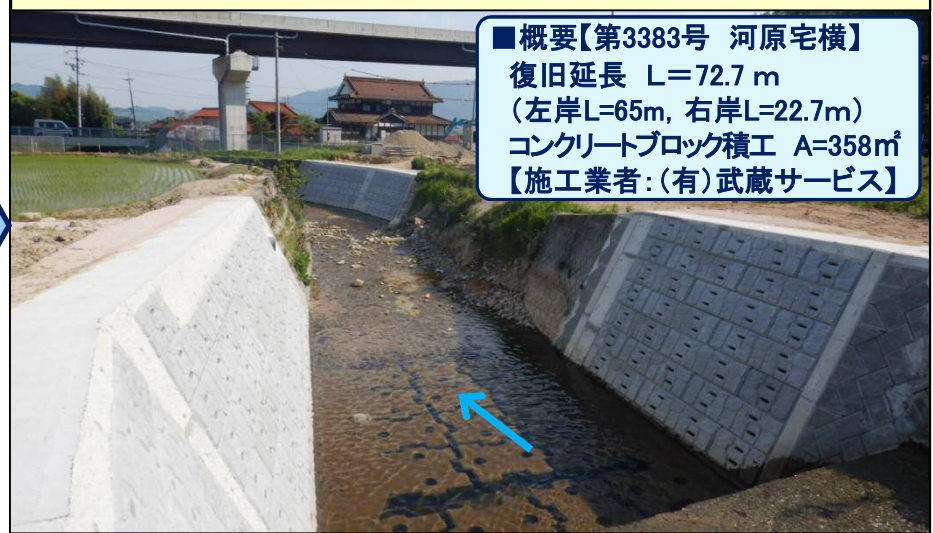
河川護岸の災害復旧工事が完成(令和2年5月)
