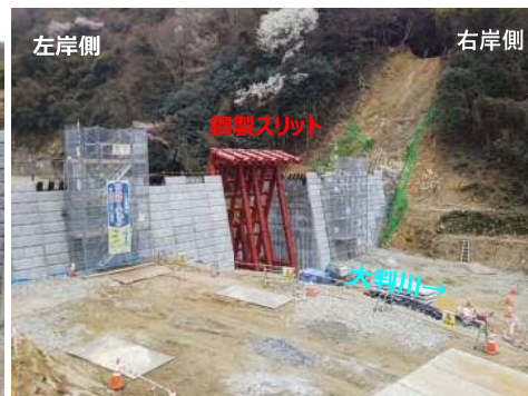
大判川施工状況（左岸側より）
