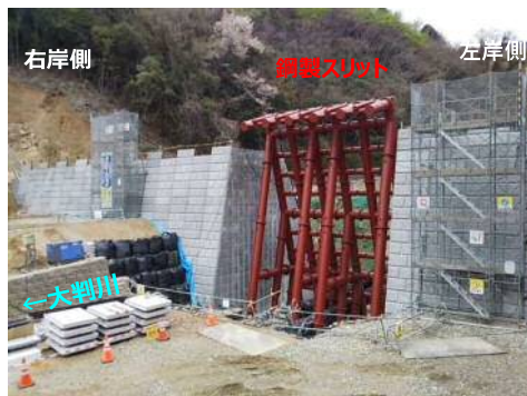
大判川施工状況（右岸側より）
