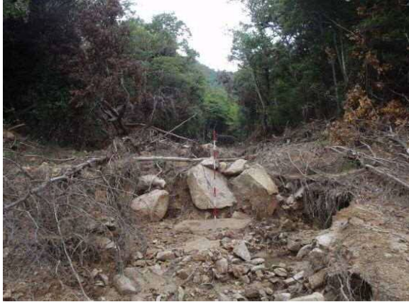
【工事前の溪流荒廃状況】
