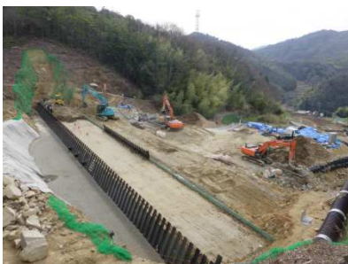
県砂防事業 中ヶ原川 (呉市安浦町)
