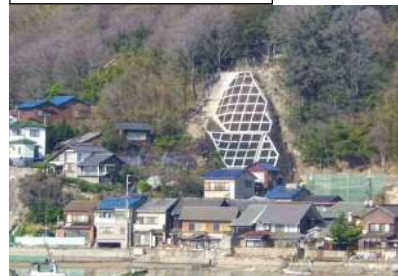
工事完了（令和2年3月27日）
