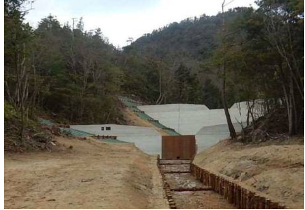
【治山ダム完成状況】
