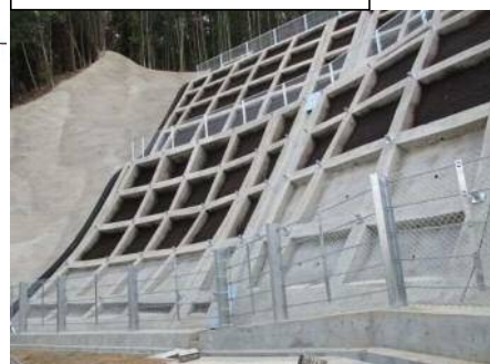
工事完了（令和2年3月27日）
