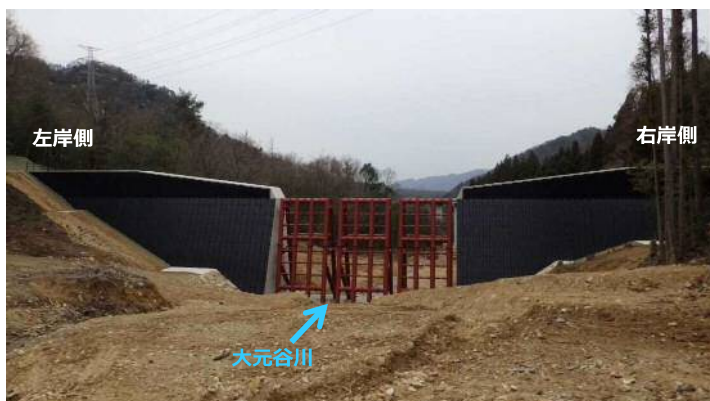
堰堤施工状況(上流側より)
