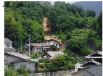
斜面崩壊・被災状況（H30年7月）
