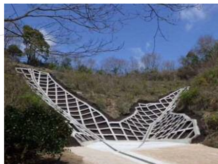
工事完了（令和2年3月24日）
