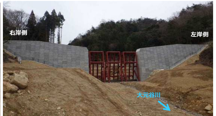
堰堤施工状況(下流側より)
