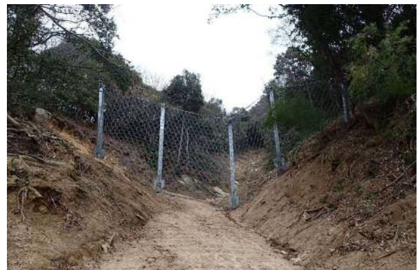
【土石流安全対策工 完成状況】
