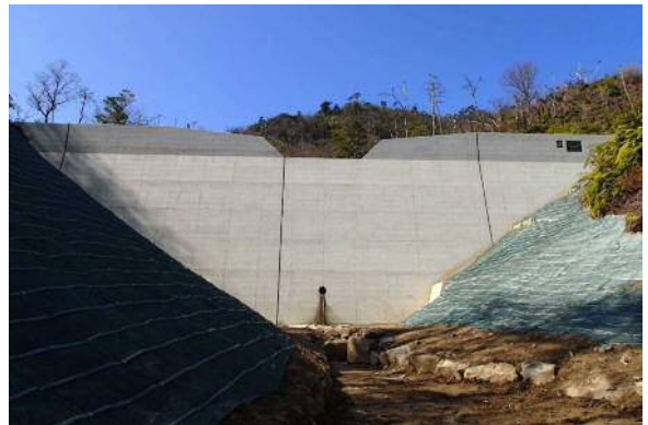
【治山ダム完成状況】
