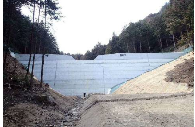
【治山ダム完成状況】
