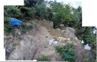
斜面崩壊・被災状況（H30年7月）
