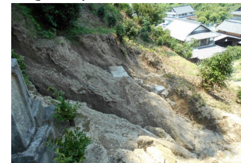
斜面崩壊・被災状況（H30年7月）
