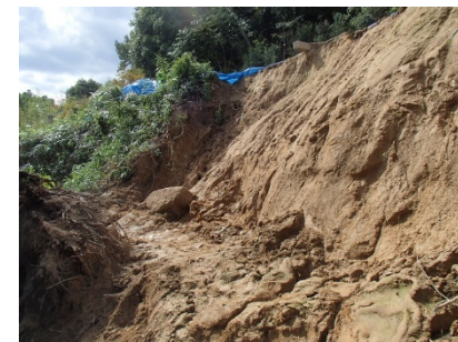
斜面崩壊・被災状況（H30年7月）
