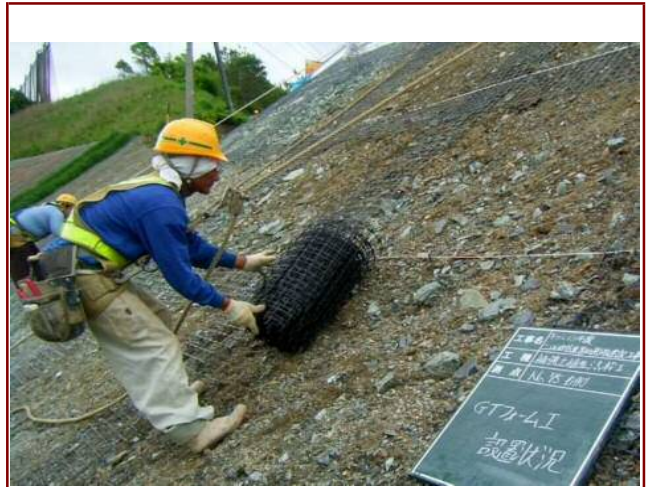
施工状況 ジオグリッド設置工
