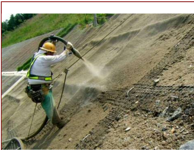
施工状況 改良土吹付工
