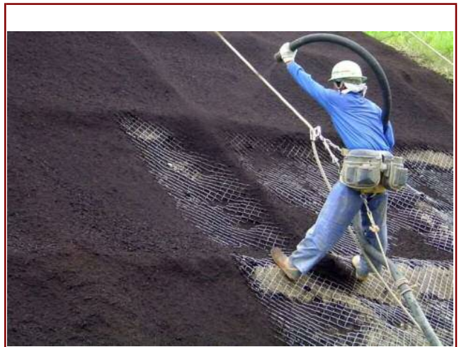
施工状況 植生基材吹付工
