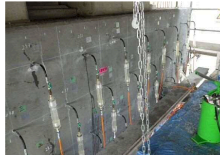
写真2：浸透拡散型亜硝酸リチウム プロコン40 注入状況
