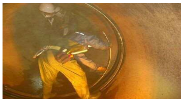
写真3：拡張バンド設置
