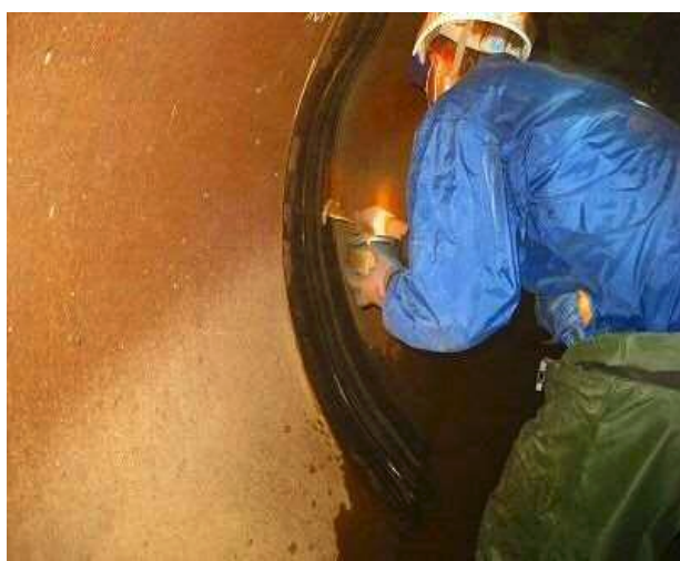
③ゴム本体取付け及び滑材塗布
