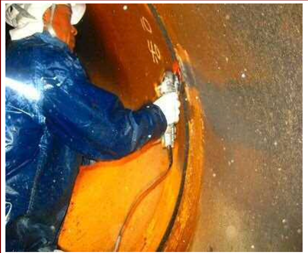
②管路下地補修
