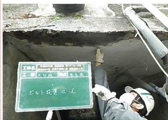
アンカー設置
