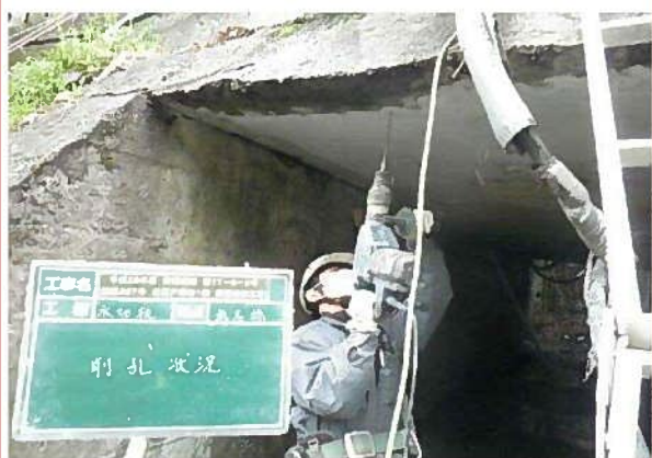
アンカー位置出し・削孔
