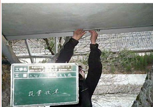
水切り板設置・ボルト締め付け
