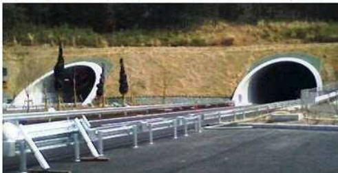
トンネル坑口
