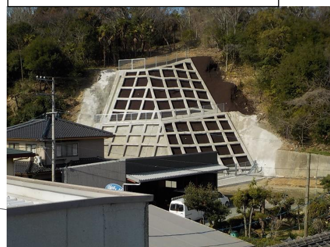
工事完了（令和2年3月19日）
