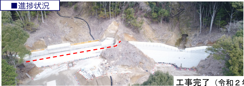
【右溪流堰堤】 緊急事業完了高さ H=5.5m
