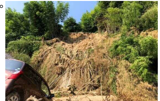
斜面崩壊・被災状況（H30年7月）
