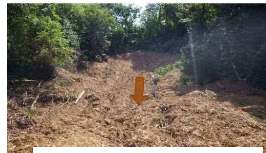
斜面崩壊・被災状況（H30年7月）
