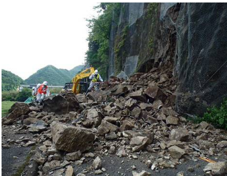
被災状況（平成30年6月）
