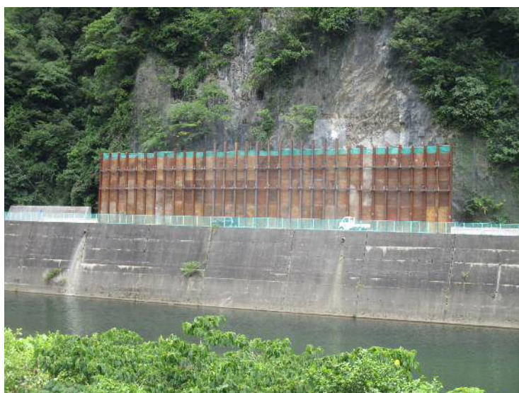
仮設防護柵の設置状況（平成30年7月）
