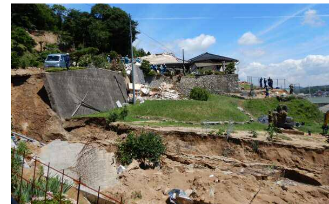
斜面崩壊・被災状況(H30年7月)
