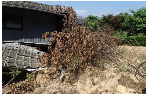
斜面崩壊・被災状況（H30年7月）
