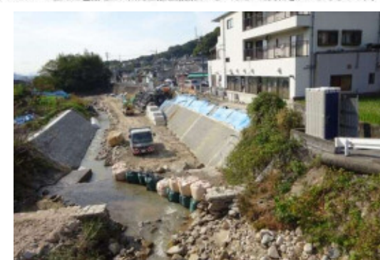
【復旧が進む被災現場】
