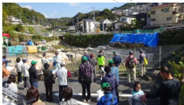
【復旧工事の説明状況】
