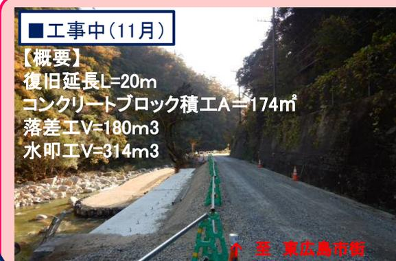
護岸工・落差工の復旧が完了
