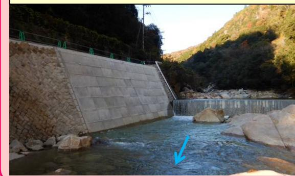
護岸ブロックを設置するため、河床を掘削中。設置するブロックの厚さは2.6mあります
