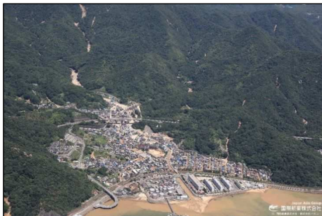
坂町小屋浦地区
