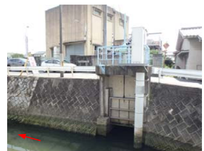
大河原ポンプ場
