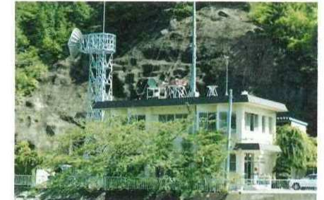
▲ダム放流警報所
