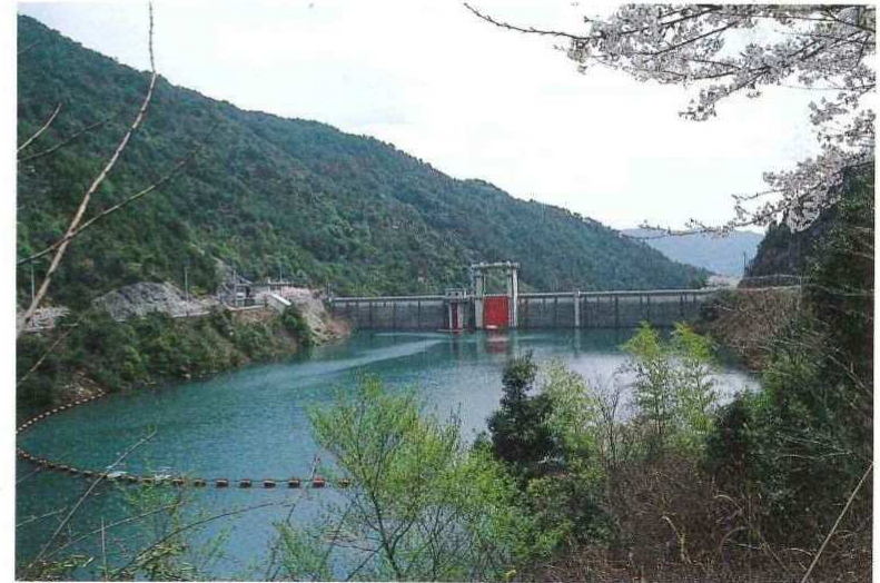
上流よりダムサイトを望む
