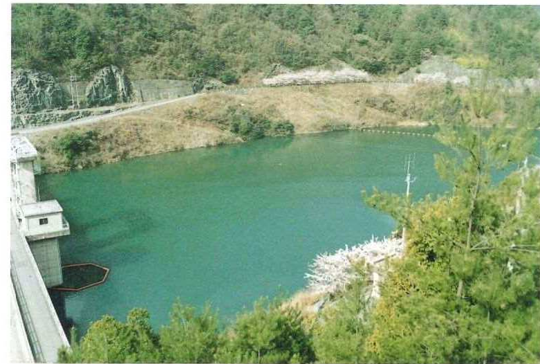
ダムサイトより上流を望む
