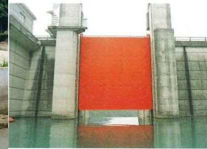
▲放流設備(クレストゲート)
