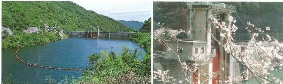
▲流木止網場施設
