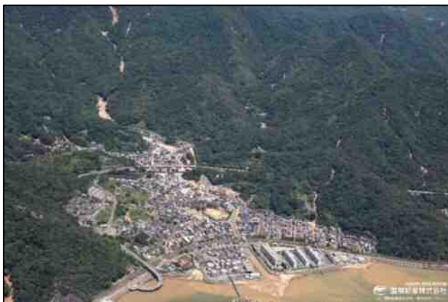
坂町小屋浦地区
