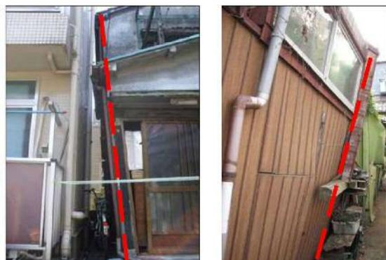
柱の変形が著しく倒壊の危険がある家屋
